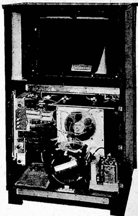
Links tegen de wand het ontvangchassis, onder het projectiesysteem en de hoogspanningsgenerator voor de beeldbuis
